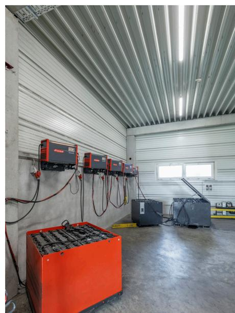
chargeurs à haute fréquence (HF) utilisés par le passé ont causé d'énormes problèmes. Les pointes de consommation qui avaient lieu lors de la charge simultanée des chariots provoquaient de fortes perturbations de fréquence dans le réseau électrique qui entraînaient régulièrement des pannes informatiques. Des restrictions importantes de l'activité de l'entreprise et des coûts inutiles s'en suivaient.
